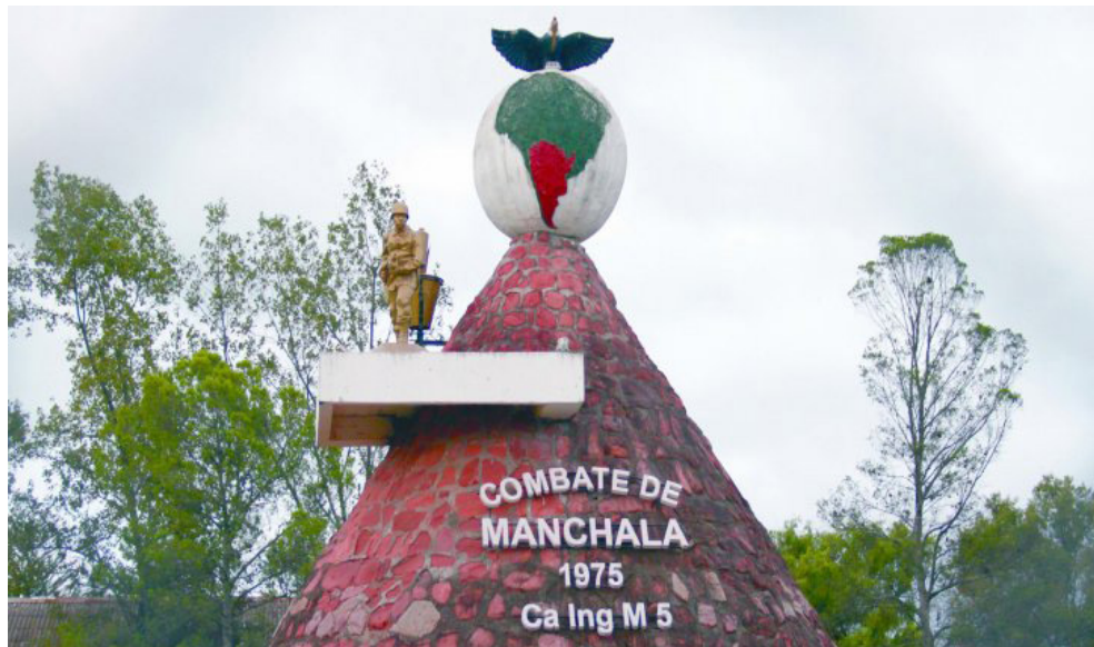
Anexo: Fotografía El monumento a Manchalá, previo a su demolición
